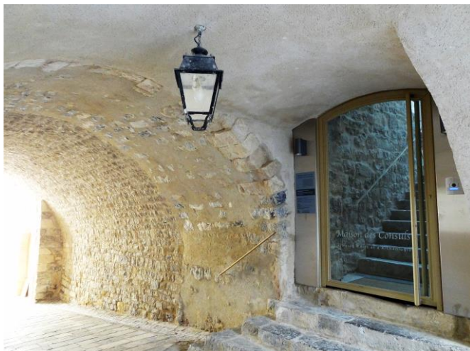
Entrée principale sous les arcades historiques.
